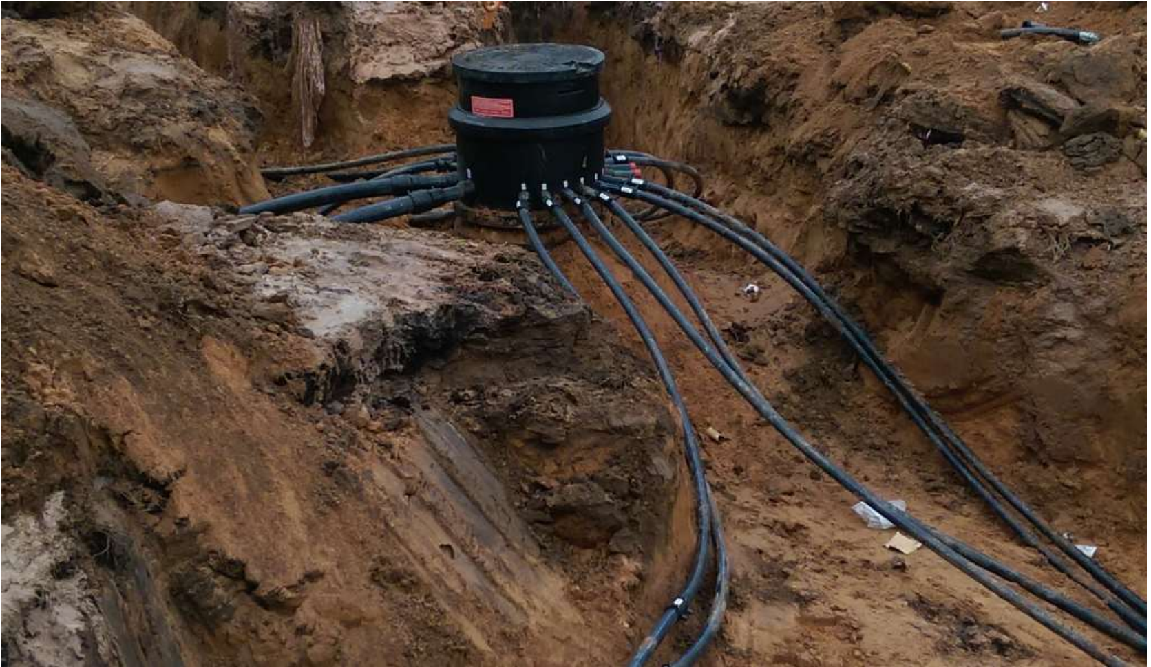
Геотермальный колодец с горизонтальными участками
